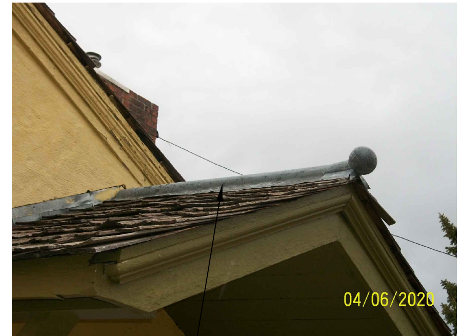
REMOVE & REUSE EX. METAL RIDGE ROLLS
